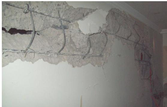
Fig. 2.7: Daño observado en edificio de Ñuñoa
